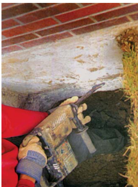
Vysekání zářezu v základech pro upevnění příruby
