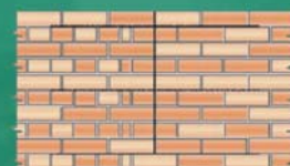
9. Vytvoření zděného nosníku
