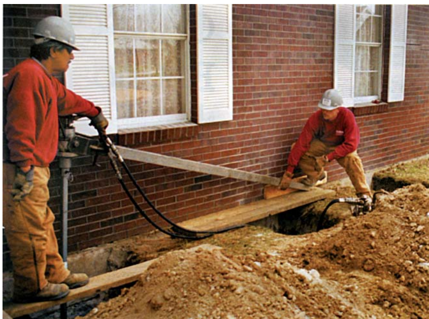
Instalace šroubových pilot pomocí hydraulického zařízení
