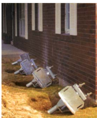
Nástavce šroubových pilot jsou odpojeni a následně jsou připevněny přírubě
