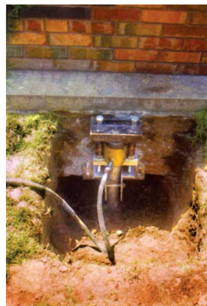
Hydraulický zvedák tlačí dolů na nástavce šroubových pilot a nahoru na základy držené v přírubě. Po zvedání, matice na vrchu T-trubice zabezpečí zatížení. Poté jsou zvedák a deska odstraněny k dokončení instalace.
