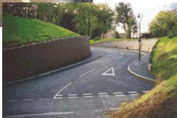
Dole - schované kotvy Duckbill v masivní blokové opěrné zdi
