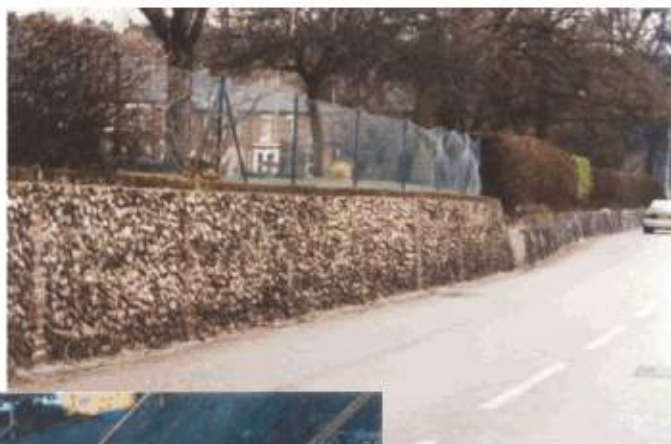
Nahoře - skryté Duckbill kotvy stabilizují amorfní opěrnou zeď
