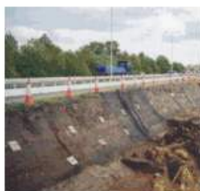
stabilizace svahu použitím kotev Duckbill
