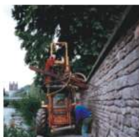
zabezpečení opěrné zdi kotvami Duckbill/Combi-Tec
