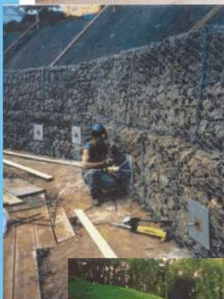
Nahoře - skryté Duckbill kotvy stabilizují amorfní opěrnou zeď
